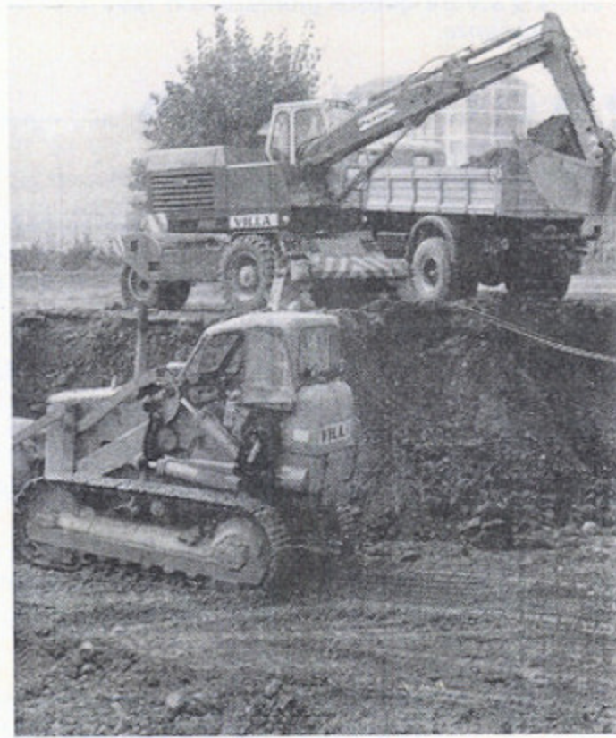
I primi scavi
